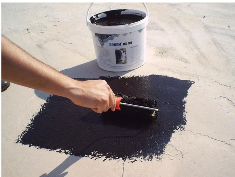
Figura 1 - Applicazione di un prodotto a base bituminosa
