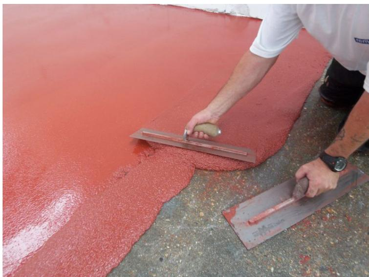
Figura 3 - Posa in opera di resina impermeabilizzante
