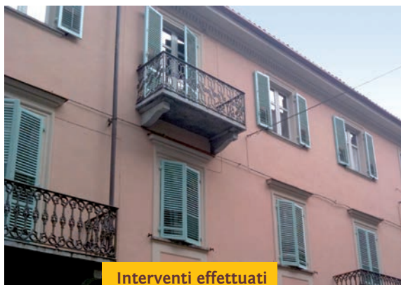
Interventi effettuati con tintura a calce.
