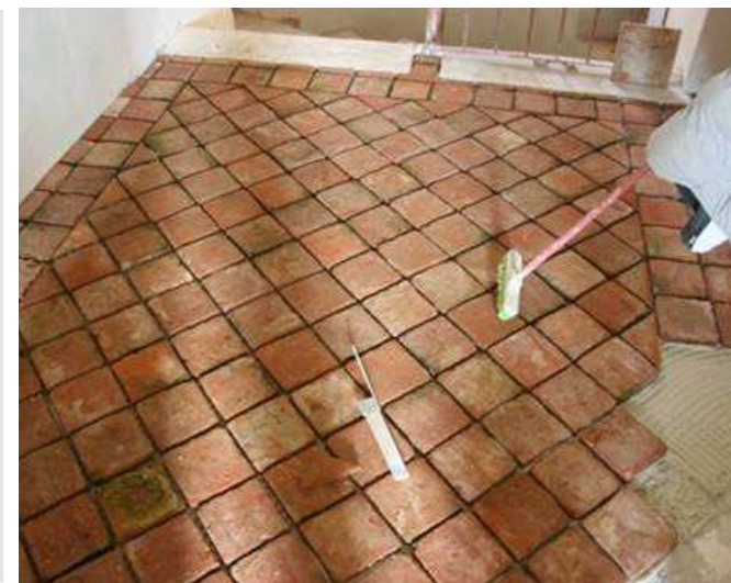
Posa in opera di un pavimento in cotto
