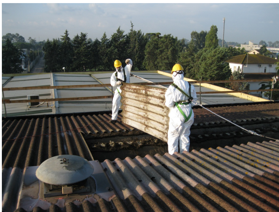
Figura 1 - Rimozione delle lastre di copertura in cemento-amianto
